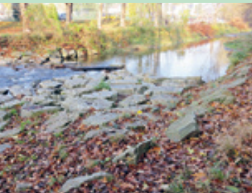
Wasserstation am Wienfluss
